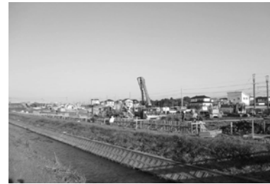
▲新駅ロータリー工事
